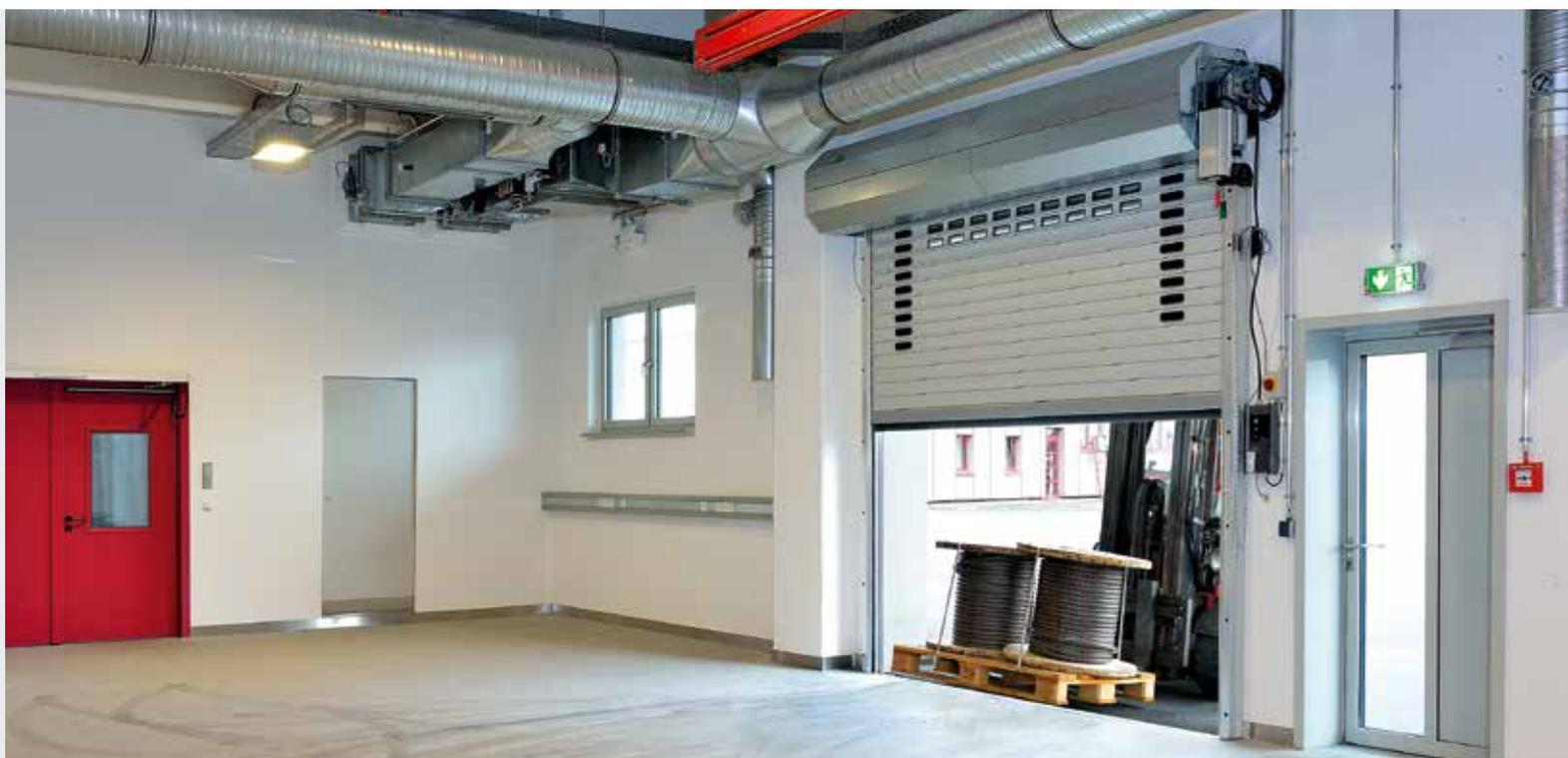
La vitesse élevée d'ouverture et de fermeture (jusqu'à 1,1 m/s) permet d'optimiser les processus et de réduire les déperditions thermiques.
